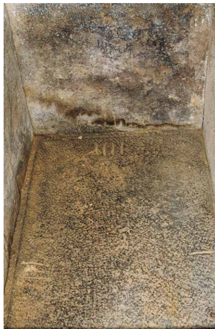
Abb. 43 | Futtertrog im Wohnstallhaus Johann Georg Wunderlich im Freilichtmuseum Landwüst. Im Inneren des Troges sind die zur Montagehilfe mit Zeichen (Ziffern) versehenen Oberflächen zu erkennen.
