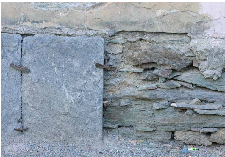
Abb. 25 Vorgeblendete Fruchtschieferplatten am Weisbachschen Haus in Plauen, Bleichstraße 5 (Zustand 2017).
