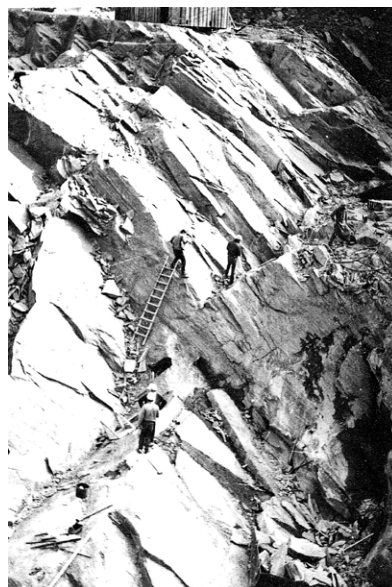
Abb. 15 | Abbau in Theuma (1955). Abkeilen eines Rohblocks parallel zur Schieferung von Hand (Privatchiv Ulrich Sörgel).
