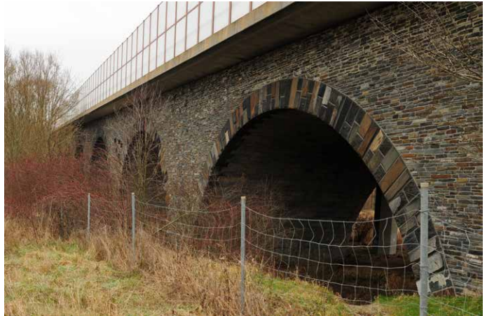
Abb. 37 | Nordfassade der alten Autobahnbrücke für die Bundesautobahn A 72 in Plauen-Sorga.
