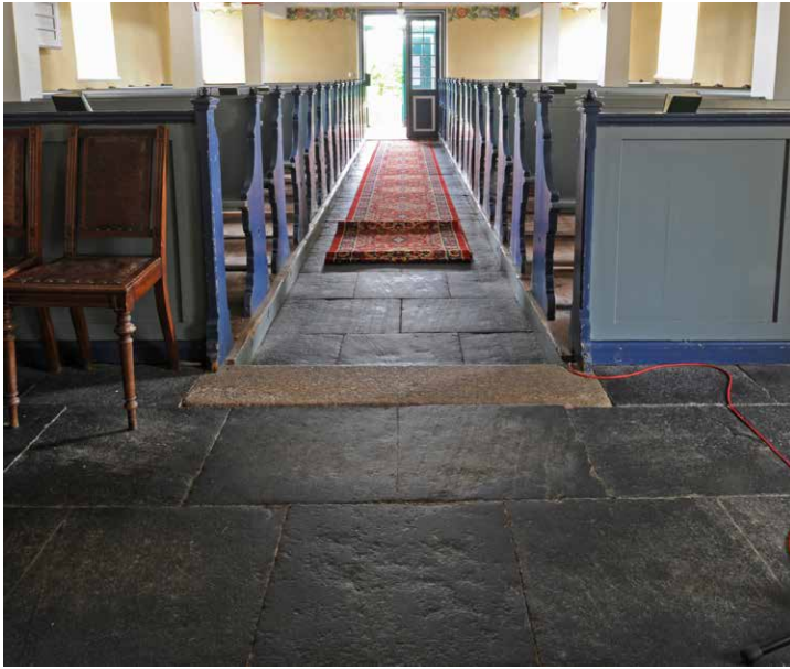
Abb. 32 | Fußbodenplatten aus Fruchtschiefer mit Granittrittstufe zum Altarpodest in der Kirche von Bergen.
