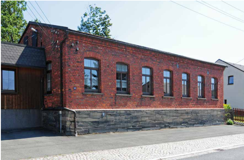
Abb. 35 | Sockelmauerwerk aus Fruchtschiefer in Kottengrün, Kottengrüner Hauptstraße 31.
