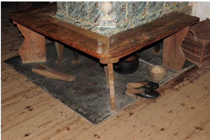
Abb. 34 | Brandschutzbelag aus Fruchtschieferplatten im Fußboden unter dem Ofen im Wohnraum eines Bauerhauses im Freilichtmuseum Landwüst.
