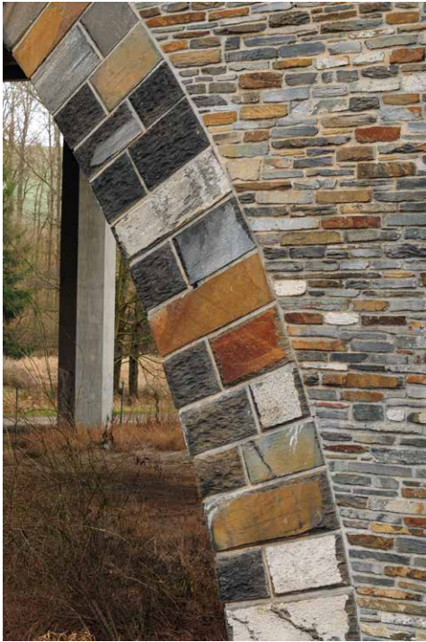
Abb. 38 | Pfeilermauerwerk der zwischen 1920 und 1921 errichteten Eisenbahnbrücke in Plauen-Kleinfriesen.
