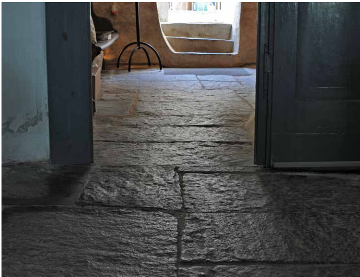
Abb. 33 | Eingangsfläche an der Sakristei der Kirche Altensalz mit handbearbeiteten Fußbodenplatten aus Fruchtschiefer.
