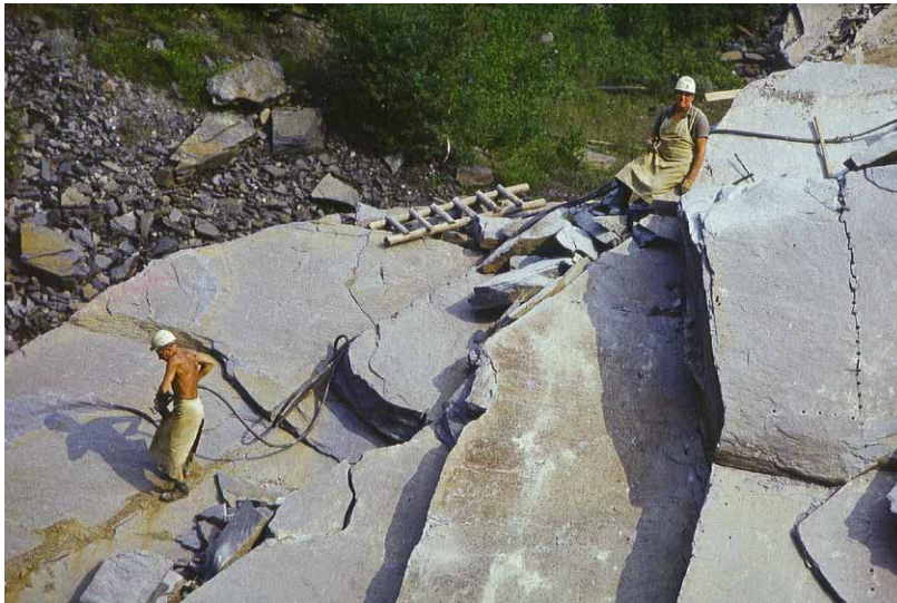
Abb. 14 | Abbau in Theuma durch Abbohren mit Pressluft und Abkeilen von Rohblöcken in den 1970er Jahren (Foto: Rolf Seuss; Privatchiv Ulrich Sörgel).
